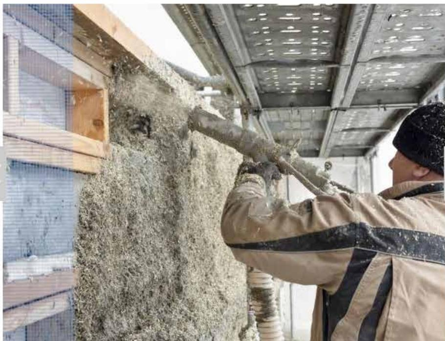
Concrètement, le béton de chanvre Tradical (constitué de chaux Tradical Thermo et de chènevotte Chanvribat), de la marque BCB (groupe Lhoist), est mécaniquement projeté par JR Bat sur des panneaux ossature bois préfabriqués en atelier et amenés au dernier moment par la société Meha Charpentes à Valenton (Val-de-Marne), affichant des dimensions de 3 à 4 mètres de large par 2,50 mètres de hauteur, fixés sur la structure porteuse. © BCB Tradical
