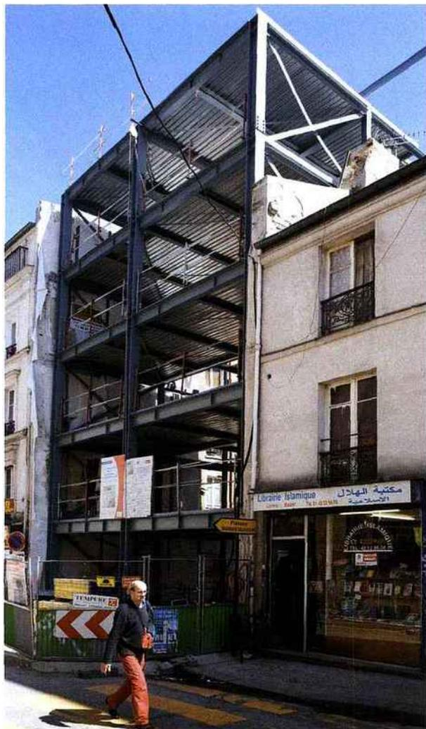
^ L'ossature métallique a été préfabriquée par portiques d'étage exactement dimensionnés entre mitoyens : version moderne du pan de mur en fer traditionnel à Paris.
